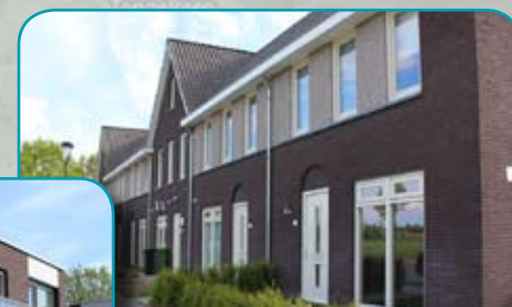
Tiliaans Noord, Bergeijk 8 huurwoningen
