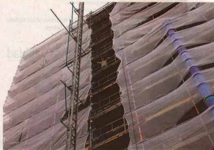
Achter doek wordt de buitenmuur van de flat steen voor steen afgebroken.
