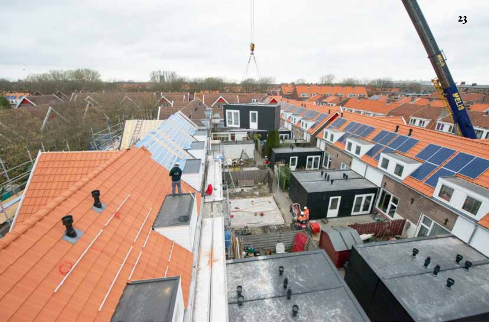
Woningcorporatie l'Escaut renoveert sociale huurwoningen in De Rooie Buurt in Vlissingen.
